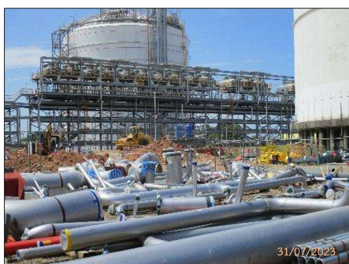
รูปที่ 2-52 การพ่นทรายทาสีที่มาจากโรงงานของ ผู้ผลิต เพื่อลดการเกิดของเสียที่หน้างาน
