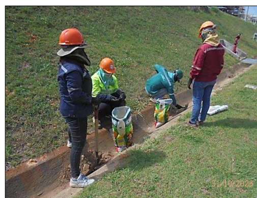
รูปที่ 2-49 การกันกระสอบทรายป้องกันเศษดินไม่ให้ไหลลงสู่ระบบระบายน้ำของโครงการ
