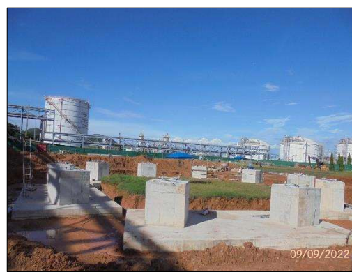
รูปที่ 2-48 การก่อสร้างฐานรากแผ่ (Spread Footing)
