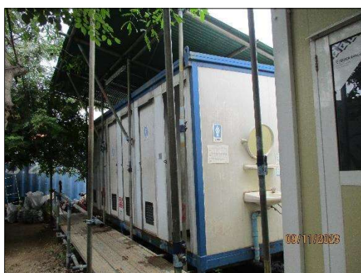
รูปที่ 2-15 การจัดเตรียมห้องน้ำ พร้อมทั้งมีระบบบำบัดน้ำเสียสำเร็จรูป
